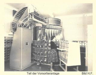
Codierplatz, links die Taschen des Vorverteilers, in der Mitte das Druckwerk, rechts die Tastatur, dahinter die Briefzuführung.
